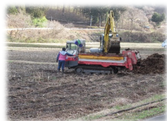
マニアスプレッタ（散布機）に積み込み
