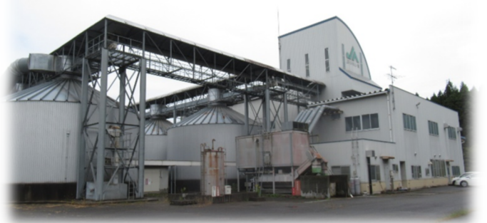
⑧千厩カントリーエレベーターで荷受けされた籾は乾燥・調製・フレコン詰めされ出荷されます。
